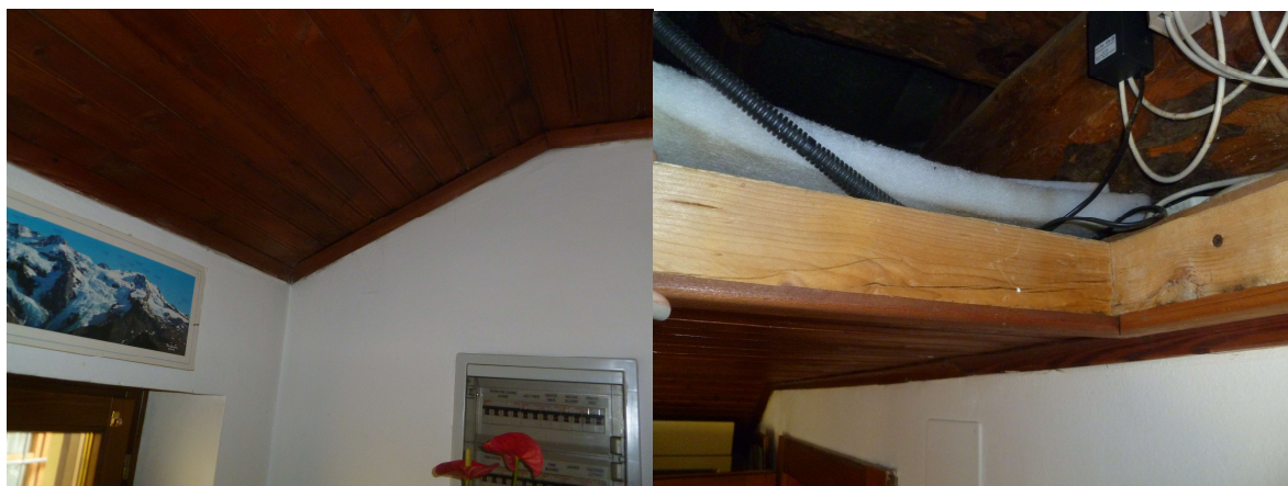
Figura 7- Controsoffitto da demolire e isolare nell'estradosso
