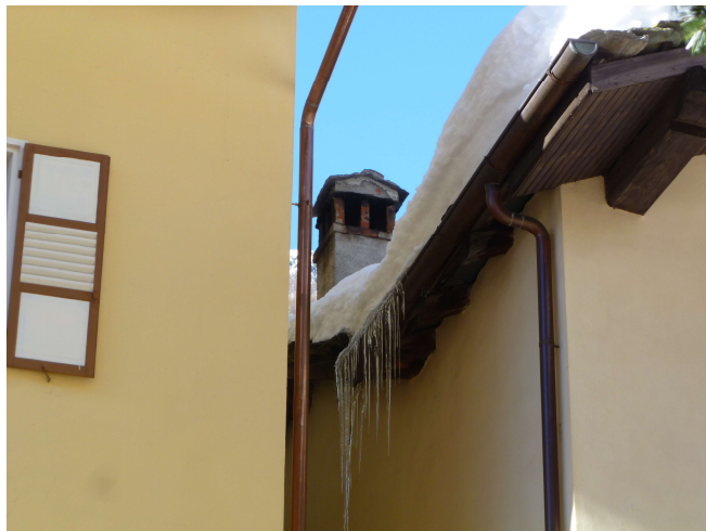
Foto 3 – Porzione alta prospetto Sud-Ovest visibile dalla piazza Umberto I
