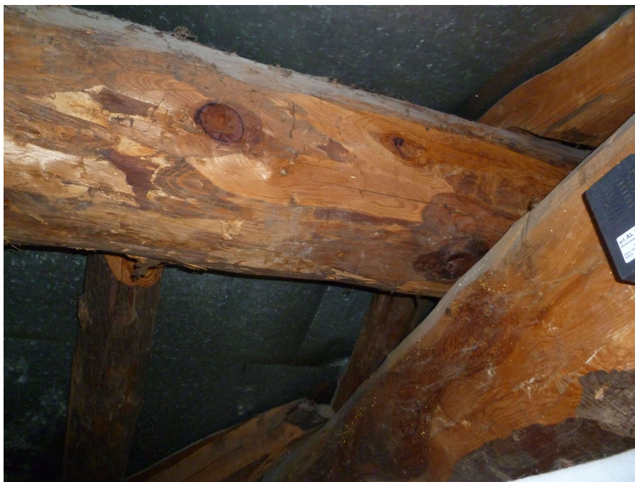
Foto 10 – Stato attuale travatura tetto
