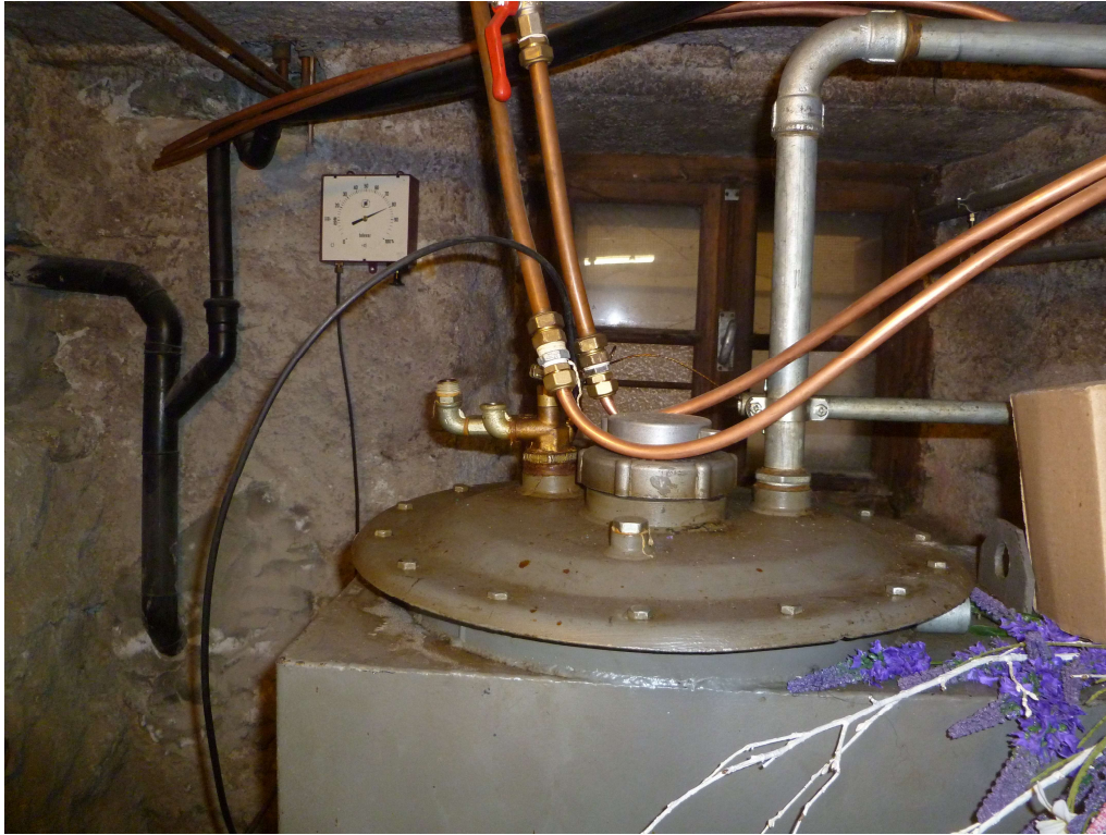
Foto 12 – Stato attuale serbatoio gasolio
