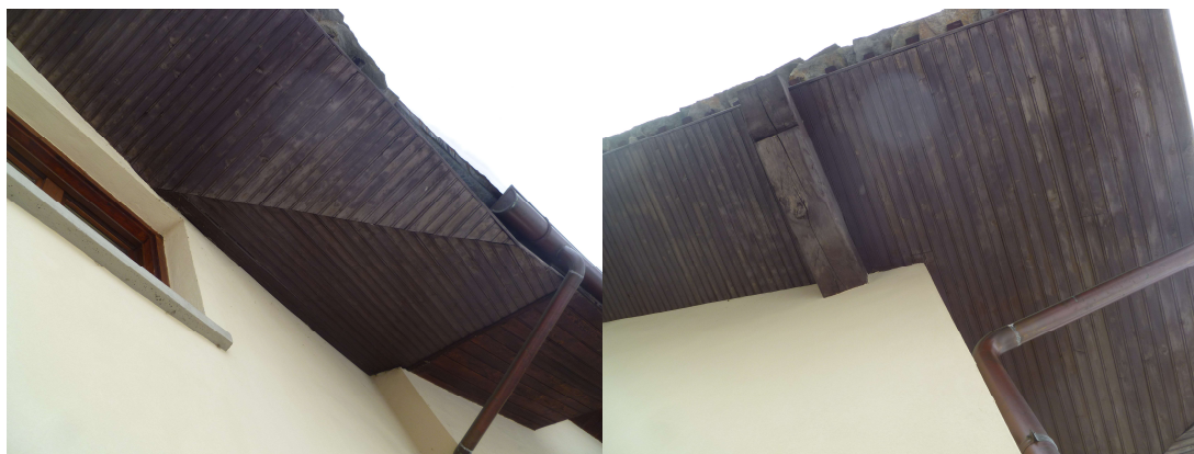
Figura 5- Tavolato intradosso della copertura in legno
