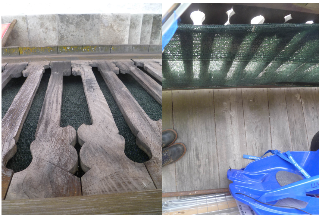
Figura 6- Parapetto e tavolato del balcone al piano primo
