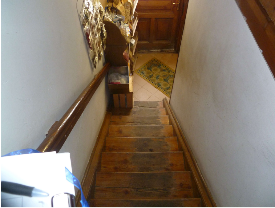
Foto 8 – Stato attuale scala interna in legno tra PT e 1P
