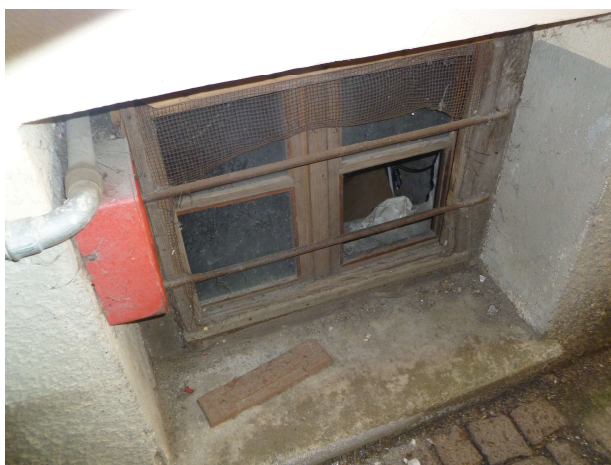
Foto 5 – Foto stato attuale serramento locale serbatoio gasolio
