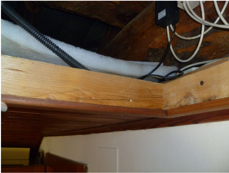
Foto 14 – Attuale controsoffitto con isolamento appoggiato sull'estradosso
